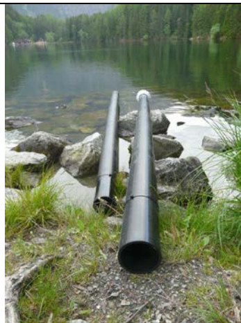
Abb. 4. Das Austauschrohr liegt bereit
