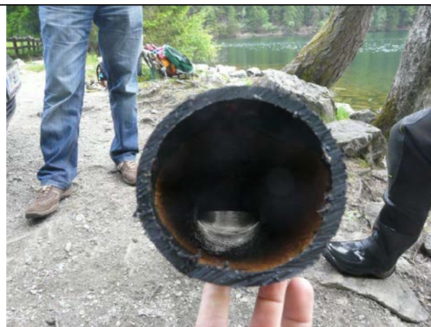
Abb. 6. Blick in den defekten Rohrabschnitt
