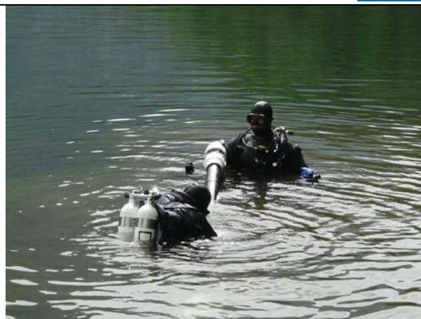
Abb. 8. Das neue Rohrstück wird versenkt und unter Wasser eingesetzt.
