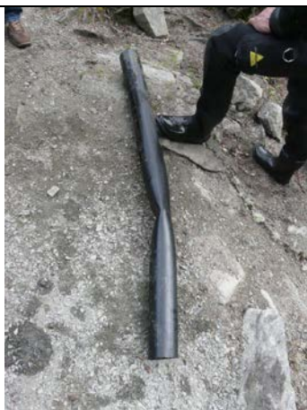
Abb. 7. Der ausgeschnittene Rohrabschnitt mit klar sichtbarer Verengung.
