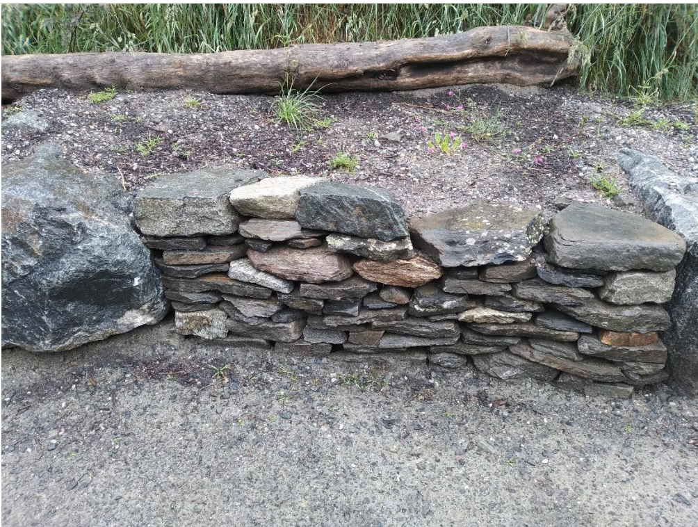
Trockensteinmauer: gebaut von den 1. Klassen der MS Längenfeld!
